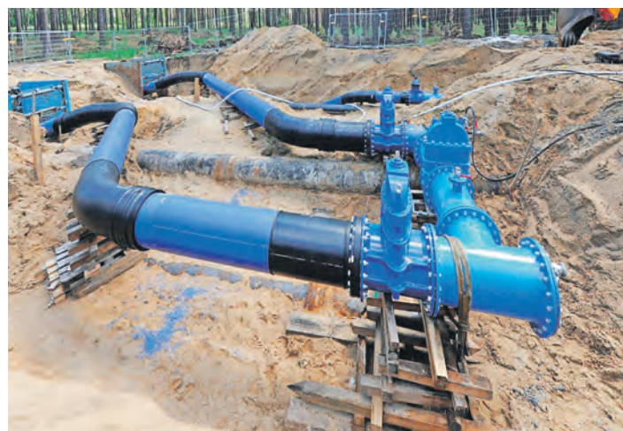
Das vorbereitete Schieberkreuz mit den bereits angeschlossenen neu verlegten Rohrleitungen. 230m mussten unterirdisch bewältigt werden. Fotos (2): TAZV/Ralf Lorenz
