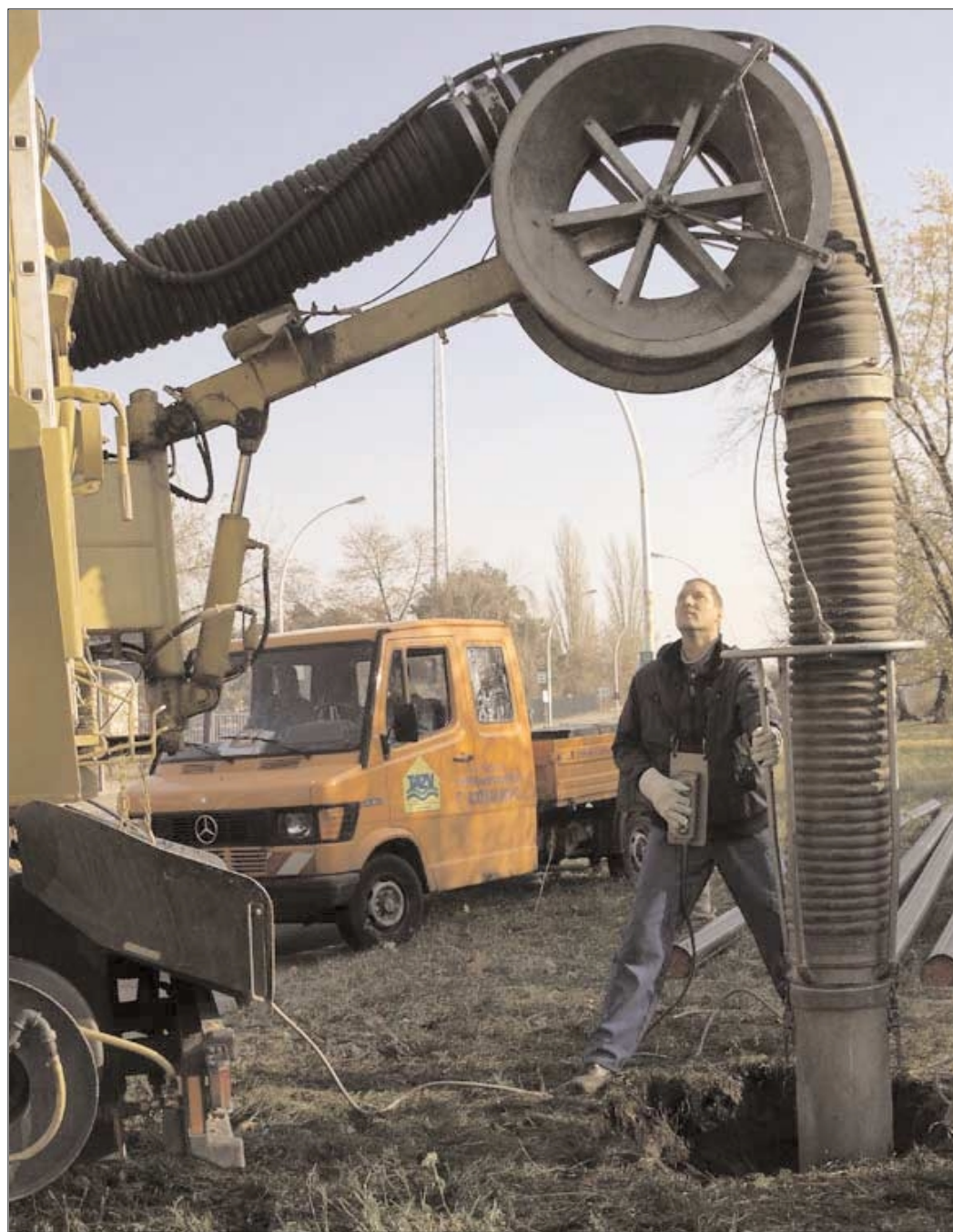
Technik, die sich durch intensiven Einsatz bezahlt macht – der Saugbagger.
