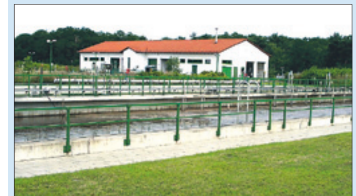
Die moderne TAZV-Kläranlage bewältigt bobo Abwasserlasten, aber als Müllkippe ist sie zu schade.
