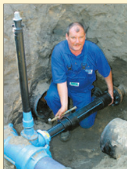
Stefan Pullner bei Montagearbeiten.
