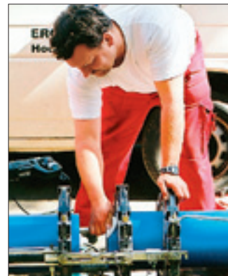
Robrverschweißung in Poblitz-Rießen mit modernster Technik.
