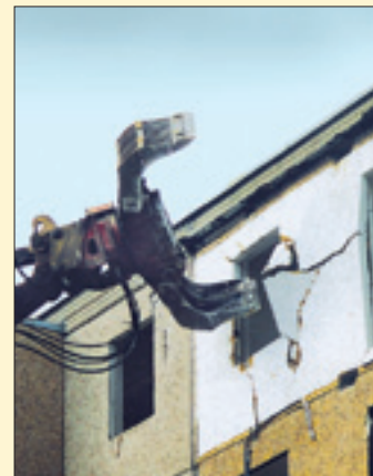
Abrissarbeiten im vollen Gange im Wohnquartier 7.
