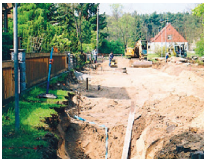
Die Leitungsarbeiten in Brieskow-Finkenheerd wurden parallel mit den Straßenbauarbeiten ausgeführt.
