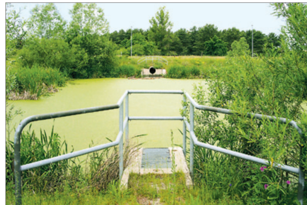
Die neuen Sandfänge reinigen das Regenwasser und sparen die teure Niederschlagsabgabe ans Land Brandenburg. (Bild unten) Bisberiger Regenwassereinlauf am Alten Kanalabstieg.
