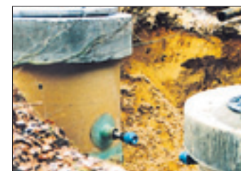
Schwerzko bekommt einen Abwasseranschluss.
