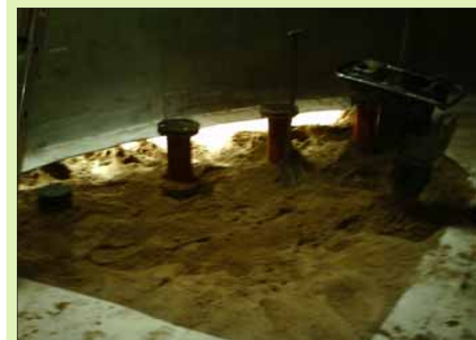
Licht am Ende des Tunnels: Ablauf, Zulauf, Überlauf und Entleerung des Behälters wurden erneuert.
