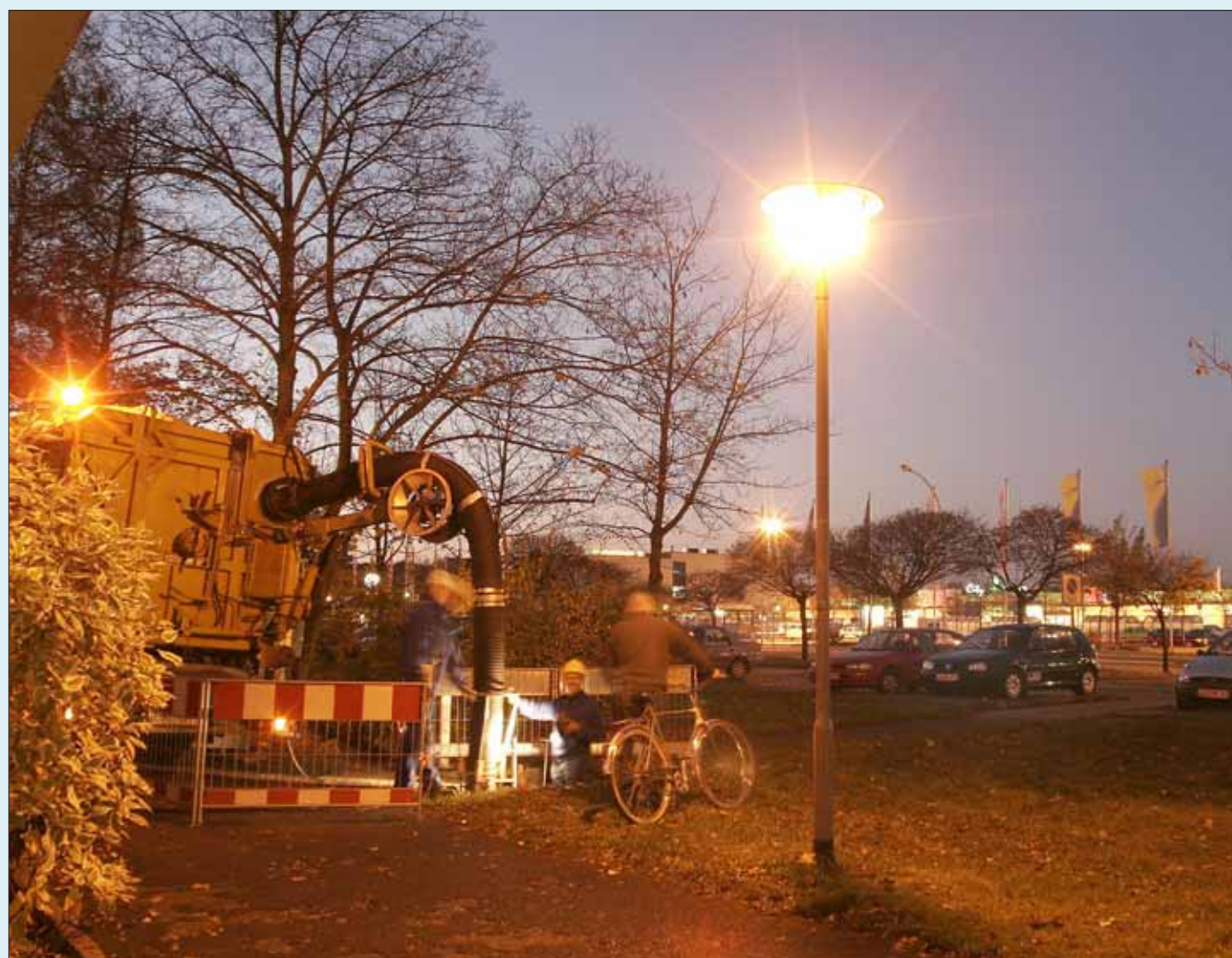
Störungen und Havarien halten sich nicht an normale Arbeitszeiten. Also rückt der Bereitschaftsdienst – häufig mit Saugbagger – auch in den Nachtstunden aus, damit die TAZV-Netze funktionieren.
