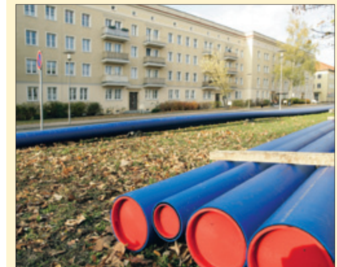
Bereit zur Verlegung – TW-Rohre aus Polyethylen.
