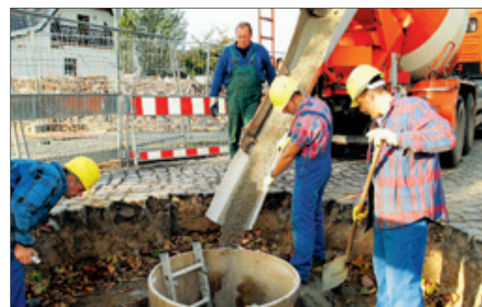
Der Spezialmörtel für die Hohlräume wird eingebracht.
