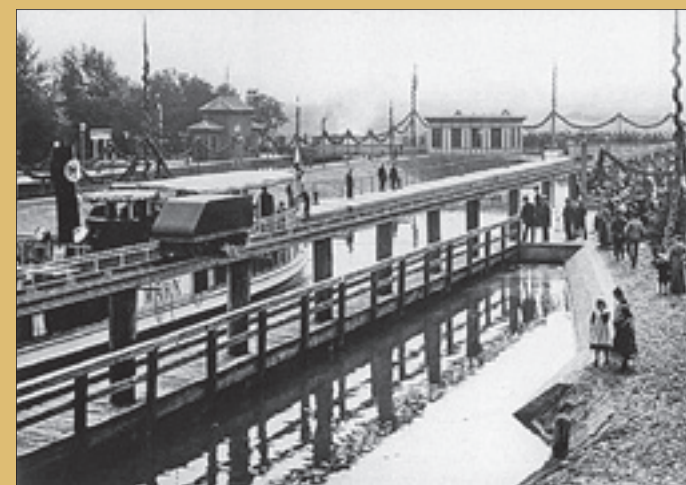
Feierliche Eröffnung der Fürstenberger Schleusentreppe am 22. September 1906: Das Foto zeigt die Einfahrt in die Oberschleuse. Heute entsteht hier der neue Sandfang (s.u.).
