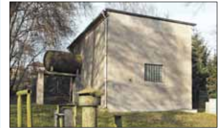
Der Lack ist ab vom Wasserwerk Schwerzko, es wird neu gebaut.
