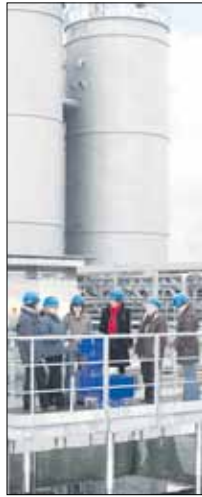
TAZV-Geschäftsführerin Heike Herrmann und die Kaufmännische Leiterin Jana Hummel besichtigen mit dem Finanzausschuss die Baufortschritte der Abwasserbehandlungsanlage.
