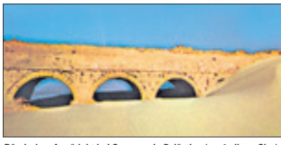
Römischer Aquädukt bei Caesarea in Palästina (ca. 1. Jh. n. Chr.). Die Leitungen bestanden meist aus Stein, wobei auch Holz, Leder und Blei zum Einsatz kamen.
