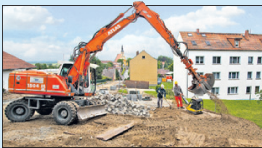
Bald ist der TAZV Oderaue mit der Sanierung der Trink- und Schmutzwasserleitungen über den Berg – zumindest den Priesberg (Neuzelle).
