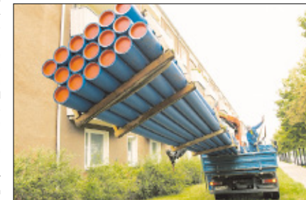
Endspurt ist angesagt bei der Leitungssanierung in Eisenhüttenstadt.
