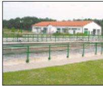
Die hoch zu lobende Kläranlage.
