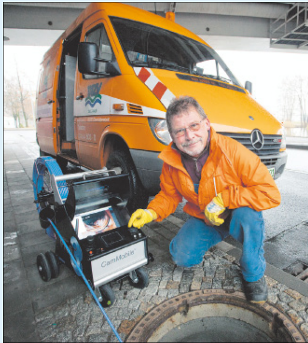
Das ist doch eine einleuchtende Arbeitsteilung: Die Kamera marschiert unten durchs Abwassernetz und Werner Artischewski lenkt und kontrolliert auf dem Monitor die nach oben geschickten Bilder.
