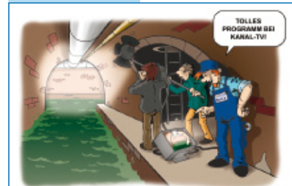
Als Kanal-TV bezeichnet man Umgangssprachlich den Einsatz fahrbarer Kameras in Leitungen und Kanälen für Untersuchungen und Inspektionen des Netzes (siehe Hauptbeitrag auf dieser Seite).
