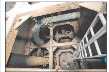
Kletterkünste sind gefordert beim Einstieg in den Dükerschacht.
