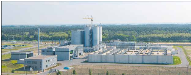
Sauber hinbekommen: Die Abwasserbehandlungsanlage sieht gut aus und arbeitet auch tadellos.
