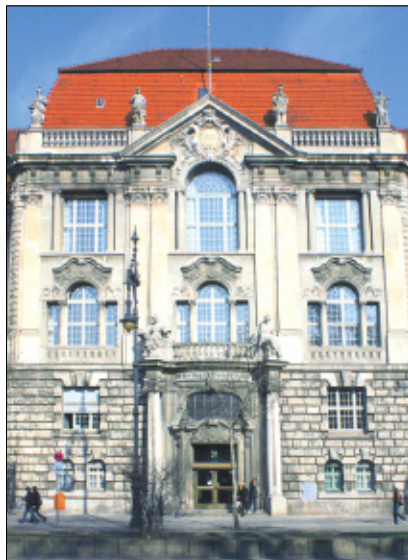
Das Gebäude des Oberverwaltungsgerichts Berlin-Brandenburg.
