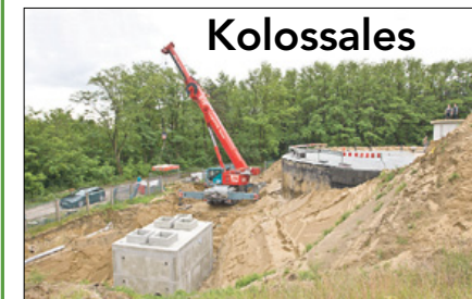
Der bullige Kran wirkt fast klein vor dem Koloss von Trinkwasserhochbehälter in der Diehler Bergen. Stück für Stück geht die aufwendige Sanierung der Speicherkammern dort voran. Die beiden großen erhalten nacheinander eine neue Innenhaut, dann sind die kleineren dran. Alle zusammen puffern mit 17.000 Kubikmetern Fassungsvermögen sommerliche Verbrauchsspitzen, vor allem jedoch sorgt ihre hoch gelegene Position für den nötigen Druck im Netz. Für die knapp 3 Mio. Euro teure Vorsorgemaßnahme nutzt der TAZV eine 55-prozentige EU-Förderung.
