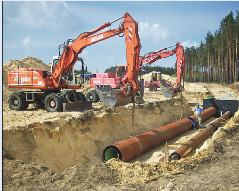
Bereits im Mai ging es am „Knoten Pohlitz“ mit schwerer Technik zur Sache: Die neuen Trinkwasserleitungen kommen sicher in den Boden.
