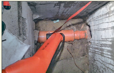
Ein Inliner wird in den Hausanschluss eingebracht.
