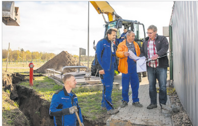
Bauleiter Ralf Lorenz (rechts) bespricht mit seinen Kollegen vor Ort die nächsten Arbeitsschritte.
