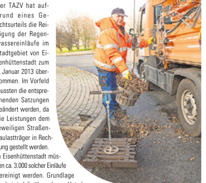
TAZV-Mitarbeiter Harald Kurreck bedient ein Regenwassertankfahrzeug. Dank des neuen Fahrzeugs geht die Arbeit leichter von der Hand.
