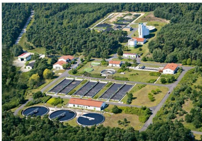
Auf der Kläranlage Eisenhüttenstadt werden jährlich 2,25 Mio. m 3 Schmutzwasser gereinigt und wieder dem Wasserkreislauf zugeführt.
