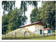
Von den Wasserwerken Pohlitz, Treppeln, Schwerzko (Foto) und Dammendorf werden täglich rund 14.500 m³ Wasser geliefert.
