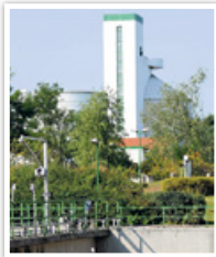
In diesem Faulbehälter wird der Klärschlamm behandelt.
