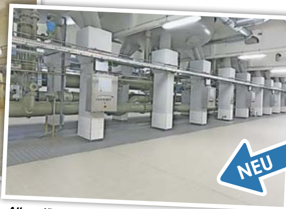
Alles glänzt schön neu – die Filterhalle nach der Sanierung.
