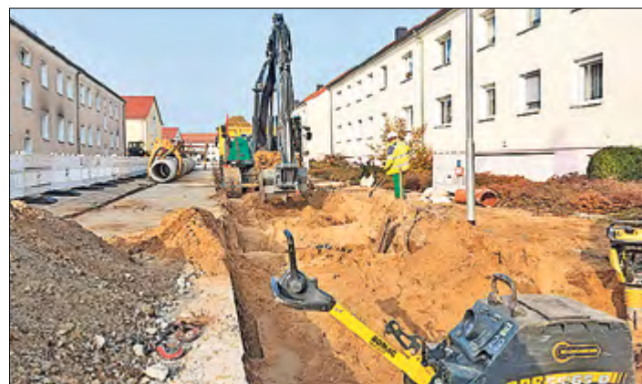
Die Baustelle in der Grünstraße Ecke Schättkeweg – hier wurden Anlagen gebaut, die Regen- und Schmutzwasser zurückhalten sollen. Foto: Bernd Geller
