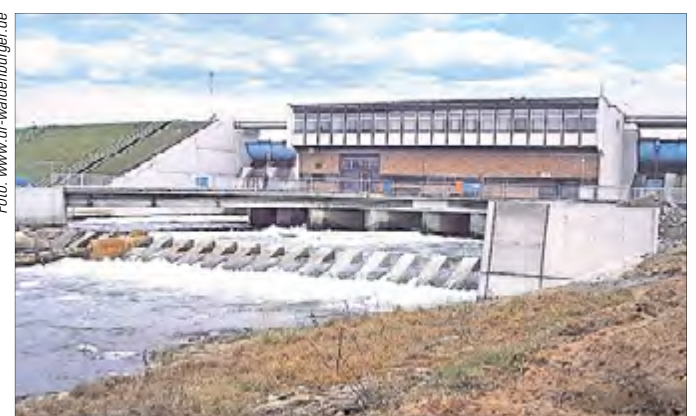
Eingebunden in den Erdstoff-Staudamm des Spremberger Stausees birgt die größte Wasserkraftanlage Brandenburgs eine Nennleistung von mehr als 1 MW. Die von 1958 bis 1965 vorrangig für den Hochwasserschutz gebaute Flachlandtalsperre ist eine technische Pionierleistung.
