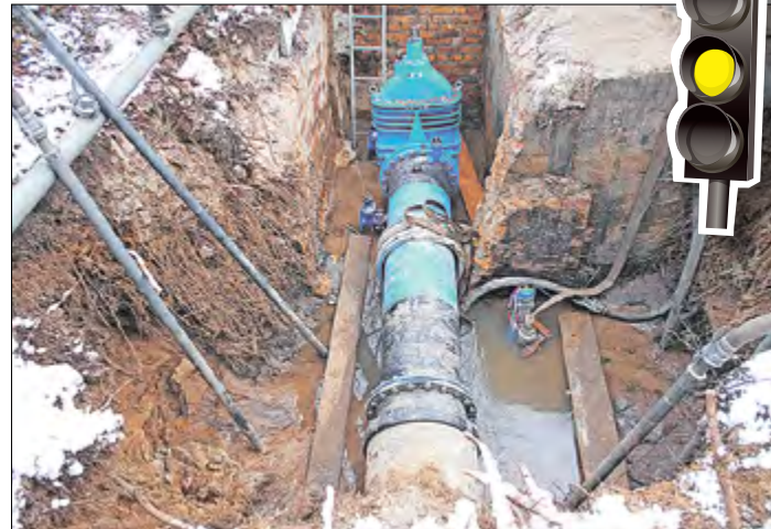
So sah die Anlage unmittelbar nach dem Einbau der neuen Armaturenstrecke aus.
