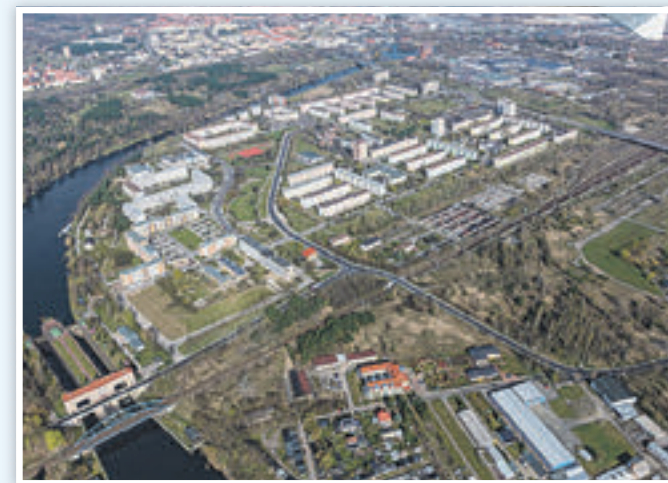
In der oberen Bildhälfte der Wohnkomplex 6, unter dem der DEGUSSA-Kanal verläuft.
