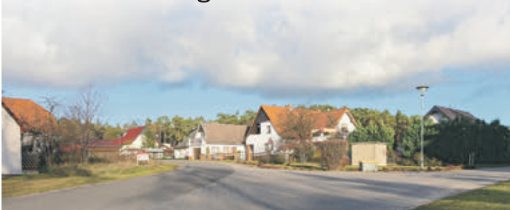
2019 wird für die höher gelegenen Straßen in Schernsdorf eine Druckerhöhungsstation gebaut.
