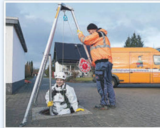
Mit einem speziellen Gerüst wird Linda Kretzschmar in die „Tiefen“ des alten Regenwasserkanals hinabgelassen.
