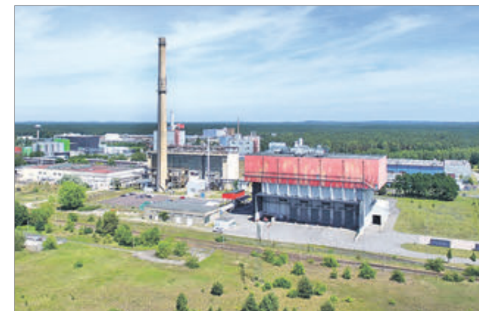
Während der Klärschlamm noch vor ein paar Jahren auf die Felder ausgebracht wurde, führt sein Weg jetzt meistens von der Kläranlage in spezielle Kraftwerke zur Verbrennung. Foto: ©EEW
